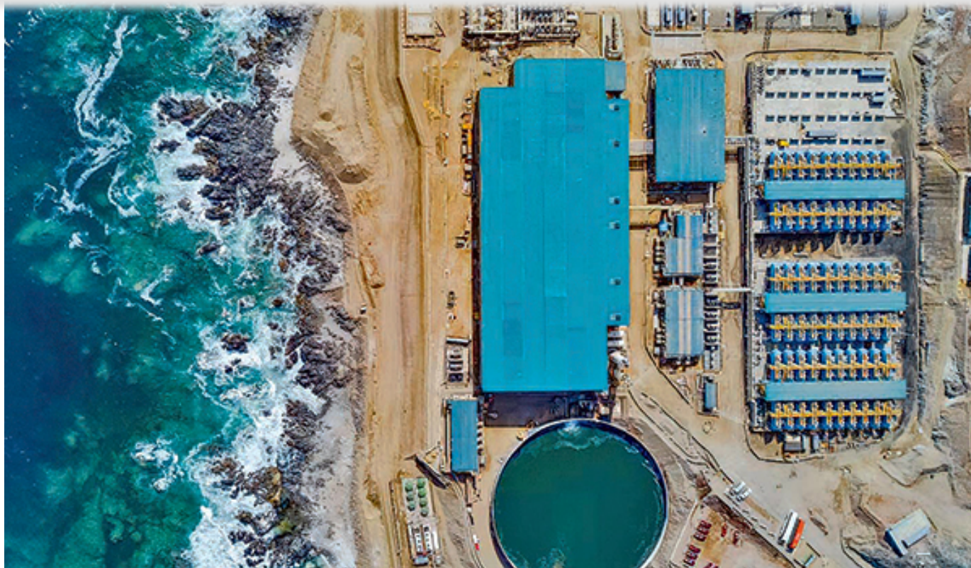
Planta desalinizadora de CAP
