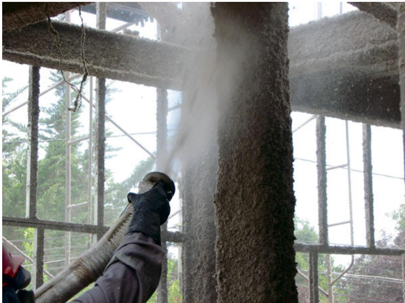
la firma chilena Accuratek creó un mortero ignífugo de aspecto rugoso que se aplica en estructuras y evita que estas colapsen en caso de incendio.
