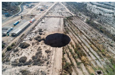
SMA y socavón en Tierra Amarilla: "Lo podemos vincular con incumplimientos de la empresa" | Diario Financiero
