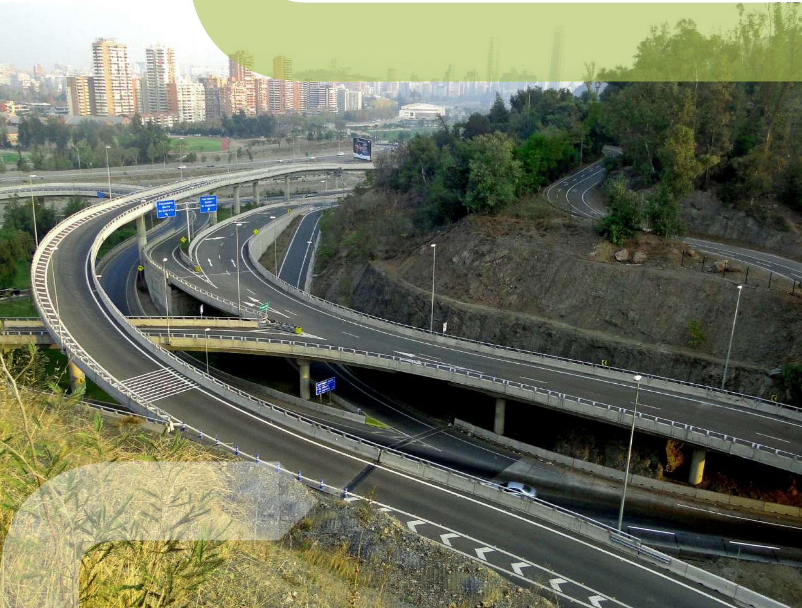
ENLACE CENTENARIO Fotografía gentileza RCQ Ingeniería.
