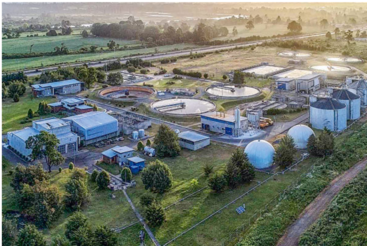
Planta de tratamiento de Aguas Araucanía
