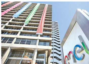
Corte de luz afecta a zonas de Providencia y La Reina
