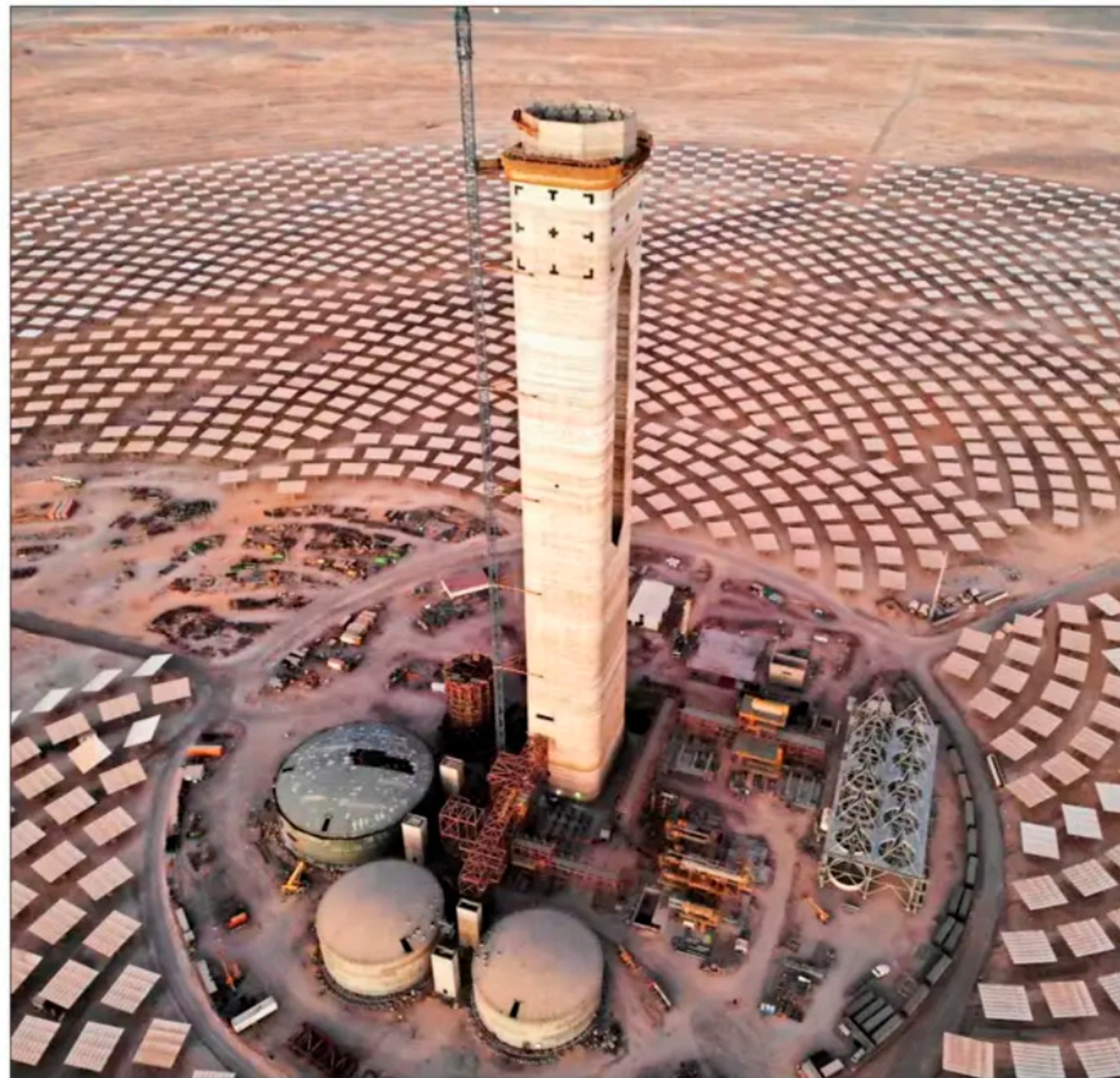
La planta tiene una enorme torre de concreto de 243 metros de altura. Si fuera un edificio sería el segundo más alto del país, después de la Gran Torre Costanera, de 300 metros.
